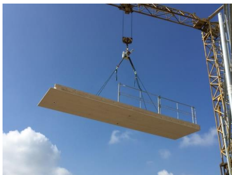
Premontaggio protezione laterale da una postazione sicura
