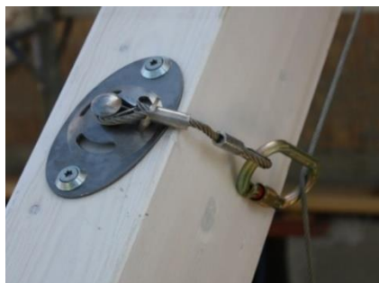
Esempio punto B: punto di ancoraggio Glarofix secondo EN 795
