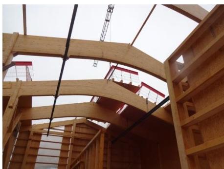
Montaggio elemento del tetto
