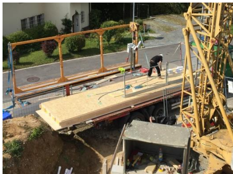
Premontaggio protezione laterale da una postazione sicura
