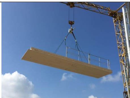
Protezione laterale da premontare (Combisafe)
