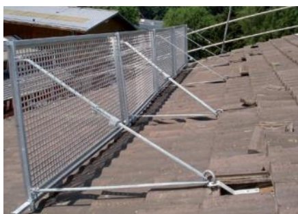
Parete di ritenuta sul tetto
